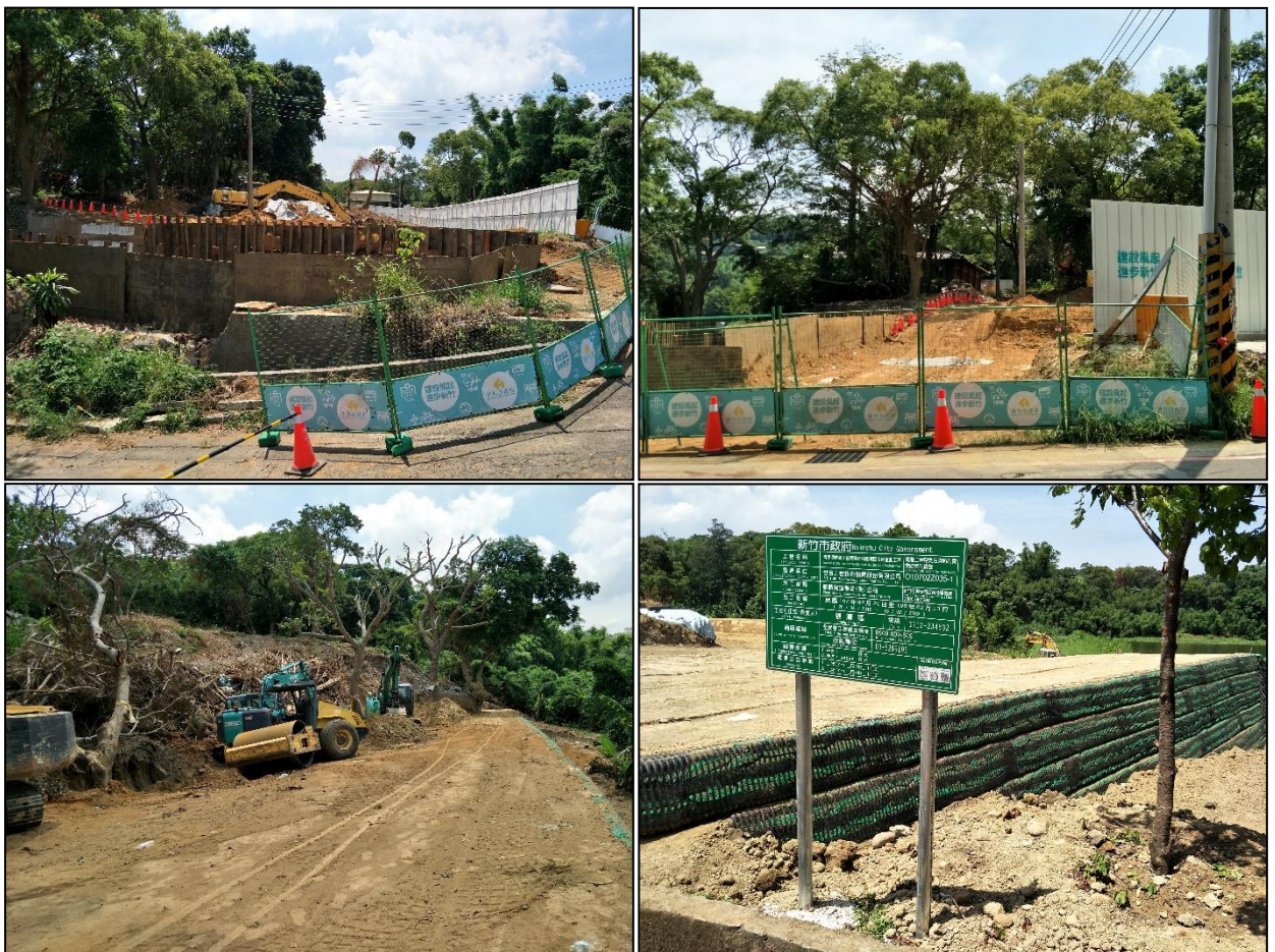
圖18 重劃區施工過程
