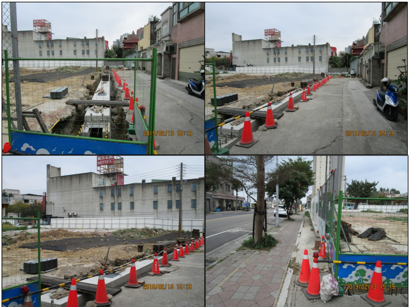
圖20 重劃區施工過程
